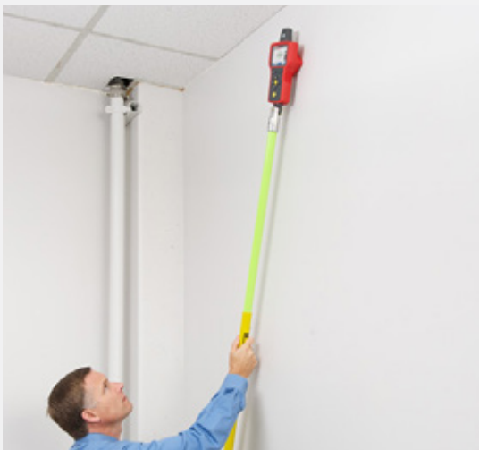
Localice cables en zonas de difícil acceso con el extensor del medidor de aislamiento.
