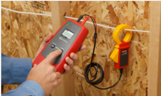
Induzca la señal con la pinza si no hay ningún conductor desnudo.
