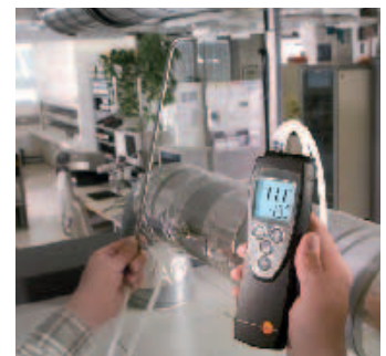
Messung von Prozessluft
