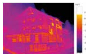
Image thermique avec testo ScaleAssist
