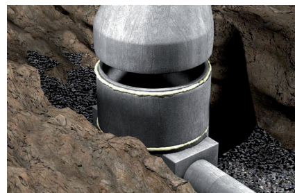
Étanchéité d'anneaux de puits en béton
