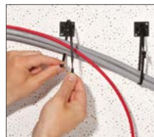
Q-tie mit Vorverriegelung bietet temporäre und finale Kabelbündelung ohne zusätzlichen Aufwand.
