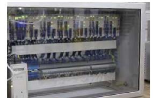
Schaltkasten mit WAGO Steuerung Control box with WAGO control unit
