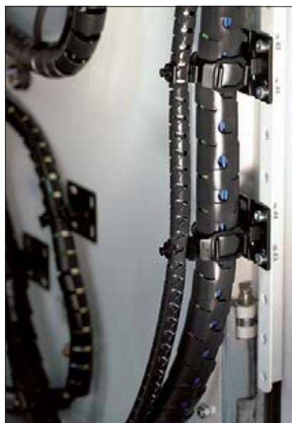
La gaine Helawrap est utilisée partout où une grande flexibilité est requise, comme à l'intérieur de panneaux électriques.
