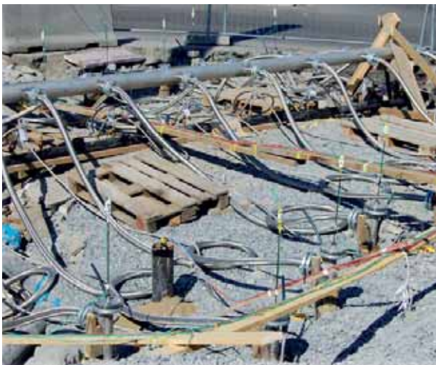
Installation de givrage au sol en cours de construction
