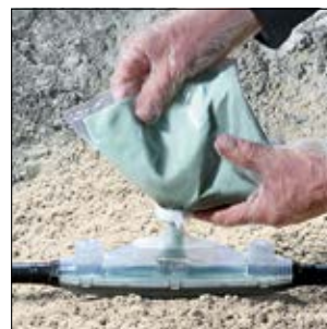
Einfüllstutz und Adapter ermöglichen eine effiziente Befüllung der Formschale.
