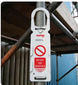
Le support indiquant l'interdiction est attaché de manière permanente à la structure de l'échafaudage, à tous les points d'accès légaux (normalement, des échelles) à partir de la première étape de la construction et doit rester sur la structure jusqu'au démontage, transmettant ainsi un message de sécurité à chacun.
