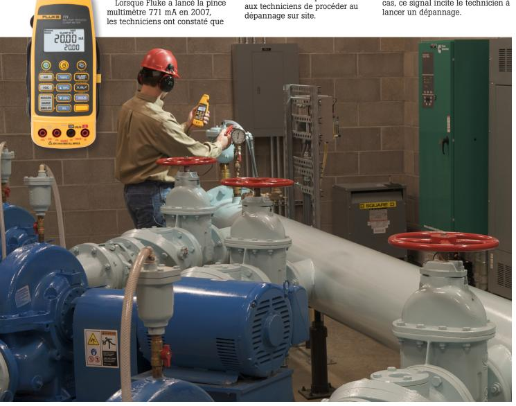
La première étape consiste à mesurer le signal 4-20 mA, soit en interrompant la boucle et en branchant un multimètre numérique en série, soit à l'aide d'une pince multimètre telle que le Fluke 771, servant à vérifier la valeur de courant de la boucle. Si le courant de la boucle mesuré ne correspond pas à la valeur attendue, les trois causes les plus probables sont les suivantes : fils cassés/débranchés/ en court-circuit, alimentation de boucle défectueuse ou instrumentation défectueuse.
