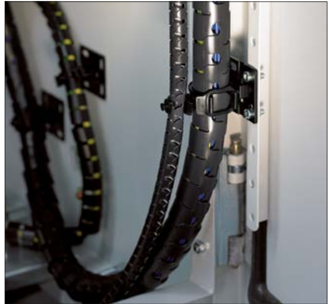
HWPP wird häufig dort eingesetzt, wo eine erhöhte Flexibilität gefordert ist, wie z. B. im Türbereich von Schaltschränken.
