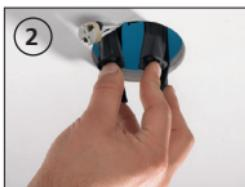
*Les 4 pattes de montage flexibles s'insèrent facilement dans la position souhaitée.*
