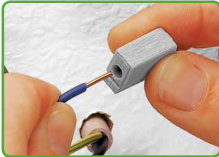
Geleider aansluiten (installatiekant): de afgestripte massieve geleider tot de aanslag in de ronde opening steken.
