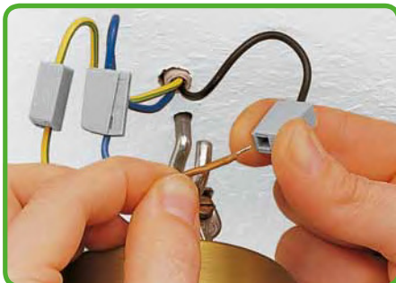
Geleider aansluiten (verlichtingskant): klem aan de zijkant met de hoekopening samendrukken en de geleider invoeren.
