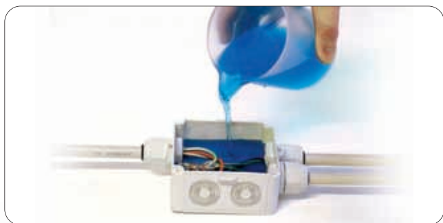
3. Pour the product in the particular to fill (1 min max) 3. Le produit est coulé dans le récipient à remplir (1 min max)
