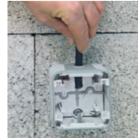
2/ Passage du câble dans l'embout.
