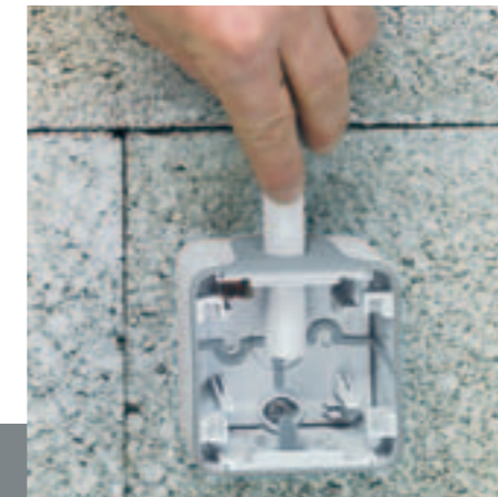
2/ Passage du tube dans l'embout.
