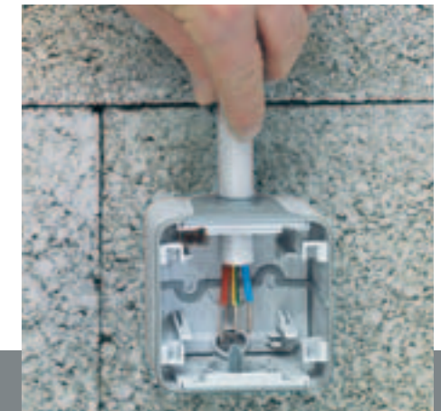
3/ La membrane de l'embout rattrape le désaxage éventuel du tube et assure l'IP 55 de l'installation.
