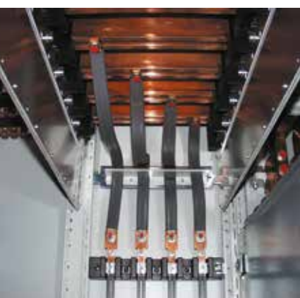
Connexion entre jeux de barres
